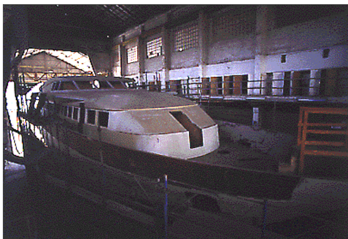
La construction nécessite de gros investissements d'infrastructures.
