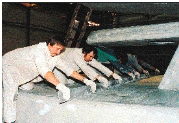
Pose de l'enduit.
