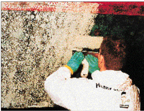
La préparation de la surface à peindre est essentielle pour un bon résultat.
