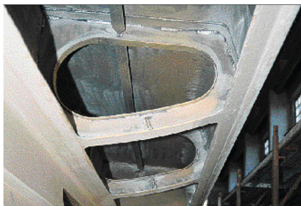
Grâce à l'utilisation de profilés, le gain de temps au montage est très important.
