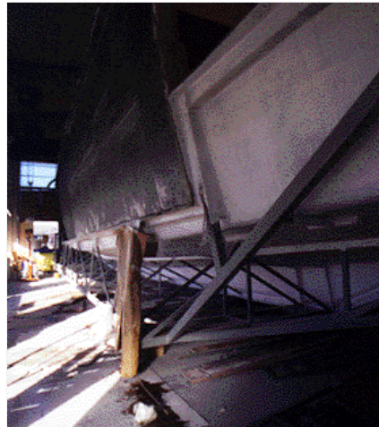
Le fond de coque est réalisé avec un moule mâle alors que les murailles sont montées sur mannequins femelles.
